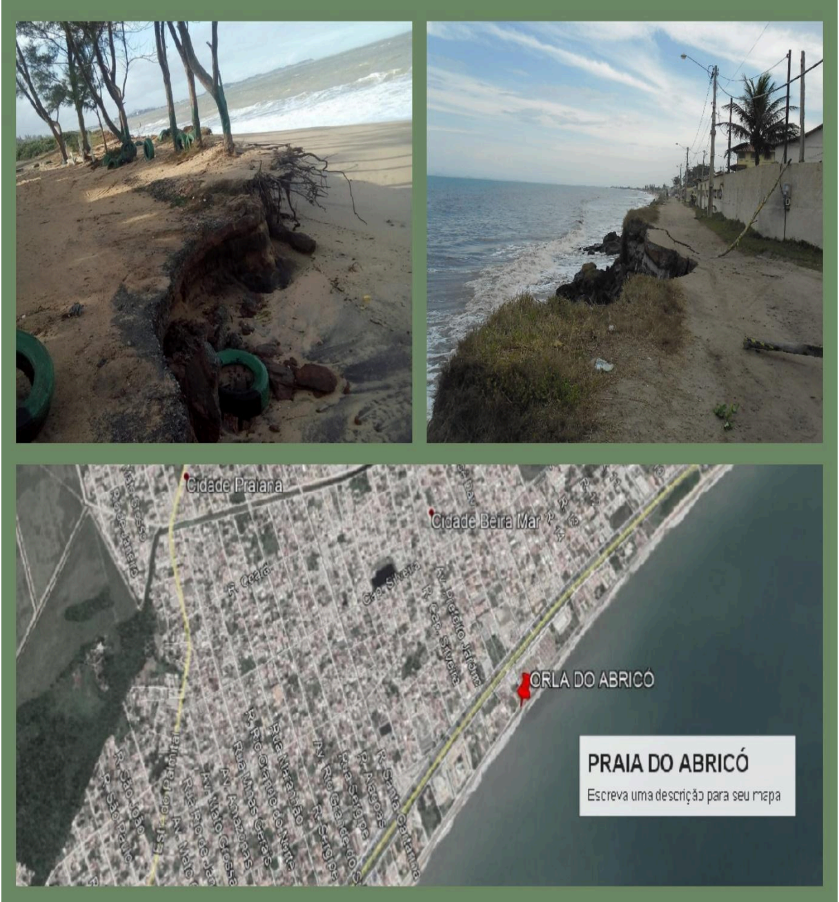
Ilustração da área afetada; Imagem Google Earth, E fotos de arquivo interno.
