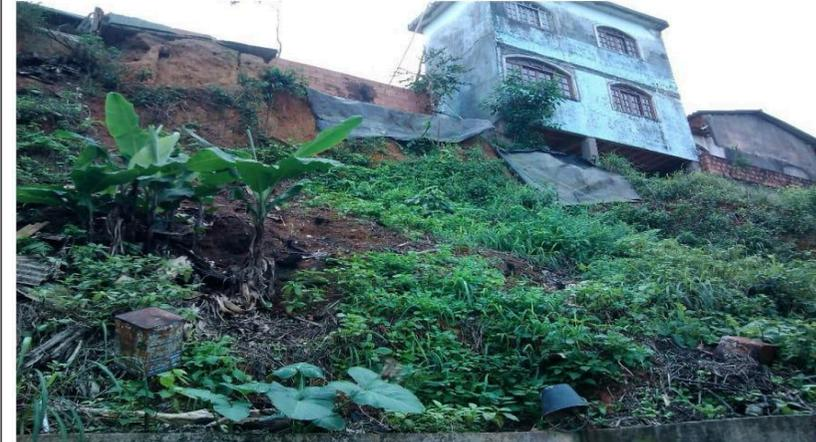
**Fatores Contribuintes:** Ocupação desordenada composta de edificações irregulares executadas sem a assistência técnica de profissionais habilitados (engenheiro, arquiteto, etc.); construções localizadas muito próximas à beira do talude existente, ausência ou deficiência de rede de drenagem, entre outros fatores.
