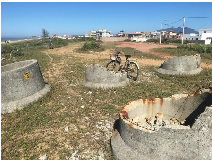
Figura 6.22 Manilhas de concreto na rua das Orquídeas, no loteamento Verdemares.
