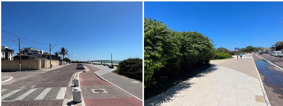
Figura 6.6 Trechos urbanizados da orla de Costazul.
