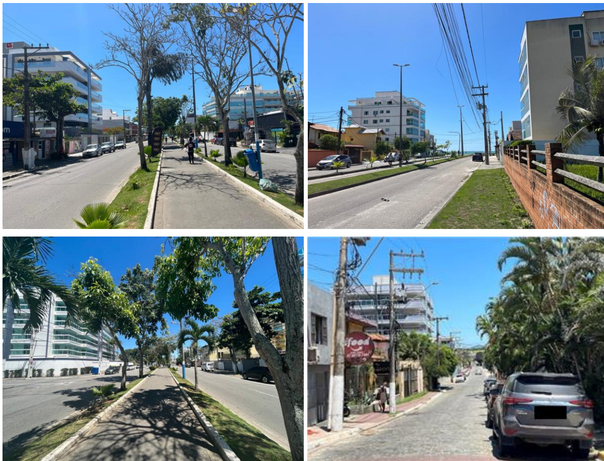
Figura 6.13 Construções nas vias perpendiculares à orla de Costazul.
